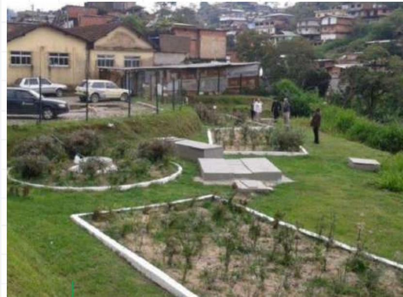
Sistema de tratamento de esgoto de Vila Ipanema em Petrópolis composto por biodigestores e alagados construídos.
