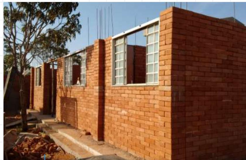
Casa de 55 metros quadrados construída com 7 mil tijolos de solo cimento.
