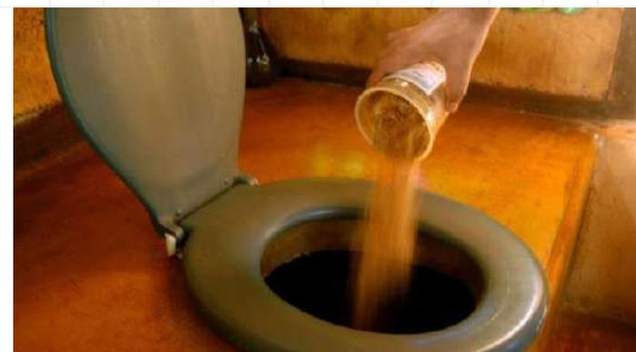
Exemplos de banheiro seco, com detalhe da manutenç o com o uso da serragem.
