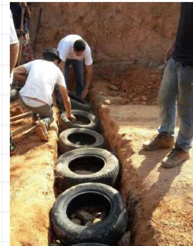
Vala de infiltração construída na ocupação Esperança, em Belo Horizonte, com uso de resíduos da construção civil e barragens de madeira. Reprodução/Fundação BB
